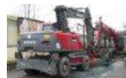
Baustelle am Bahnhof
