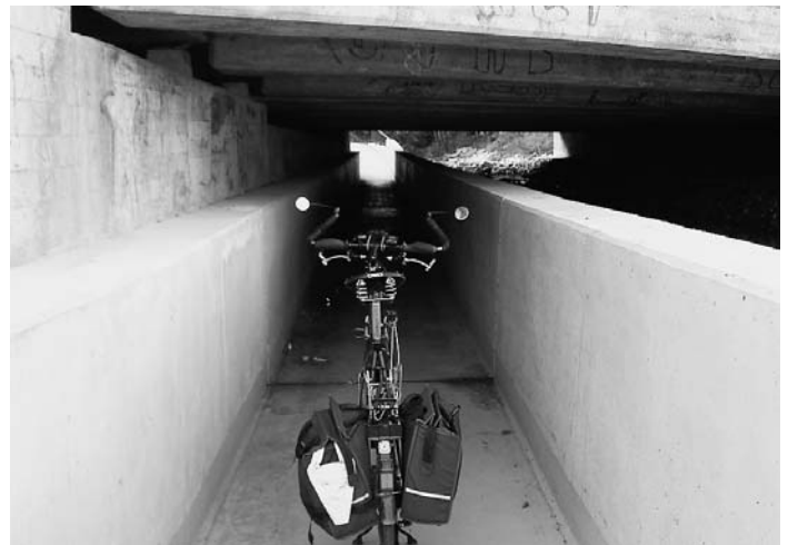
Gut zu erkennen: Die neue Unterführung der A5 mit dem Erlenbach in Friedrichsdorf ist recht niedrig ausgefallen – und ohne warnende Kennzeichnung nicht ungefährlich.
